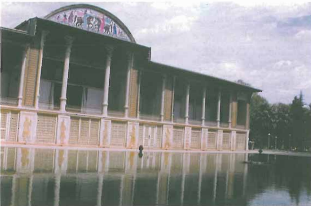
۱۶-۷- حوض بَر خاوری ی ساختمان باغ عفیف آباد
