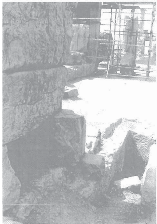
۵-۱۹ - جای برخورد آب رو دیوار جنوبی ی کاخ خشایارشا با یکی از شاخه های پسابرو زیرزمینی . سنگهای درپوش از روی پسابرو برداشته شده است - دید بسمت شمال
