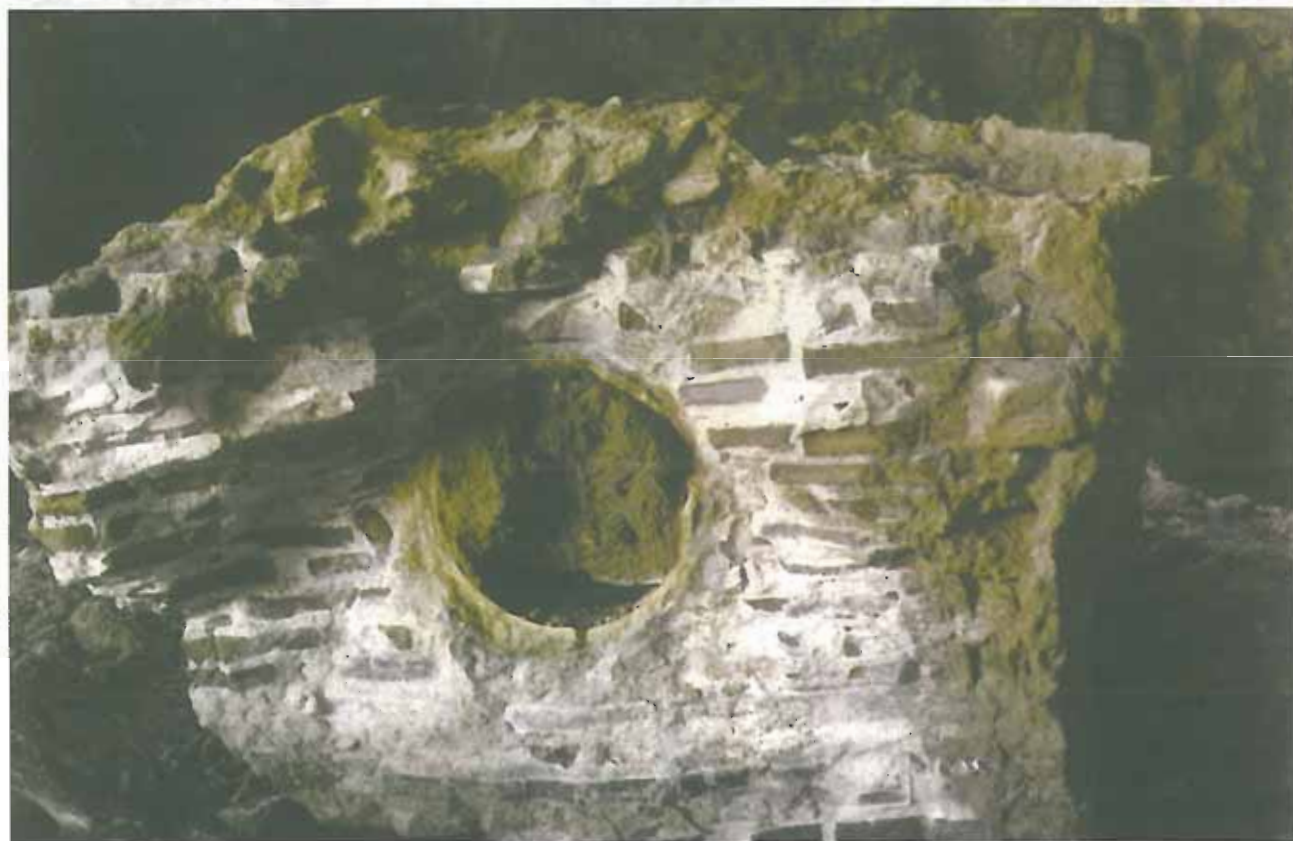
۱۹-۲-چگونگی ی چفت و بست شدن دو لوله ی سفالی
