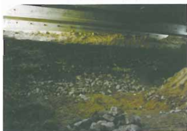
۲۶-۲- نمایی از زیرسازی و کف سازی ی حوض ویران شده ی ساختمان کلاه فرنگی ، بَرِ شمالی .
