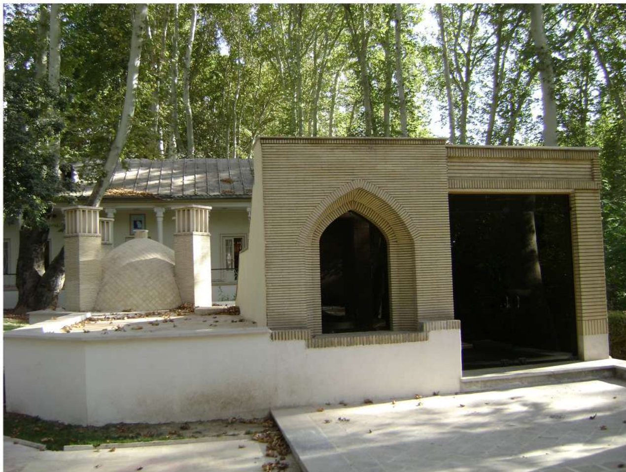
نمای بیرونی مکتب آب انبار نصر آباد یزد
