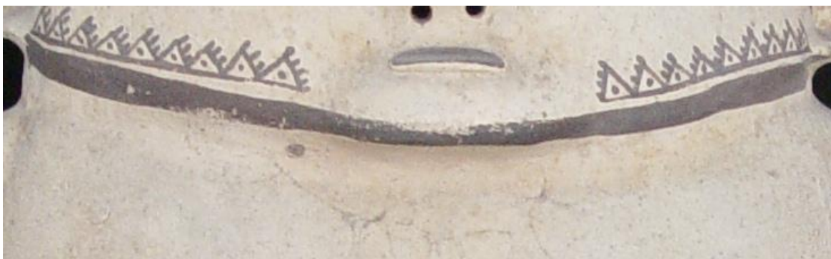
ریز ترک در سطح مجسمه
